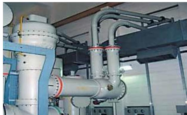
Контакты для подключения к оборудованию с элегазовой изоляцией.
